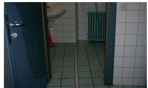
Door to toilet
